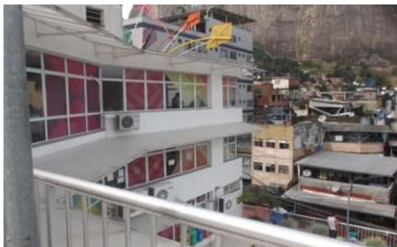
Figura 3: Lateral da Fachada da Biblioteca Parque da Rocinha. Fonte: foto tirada pela autora– 22/01/2013.
